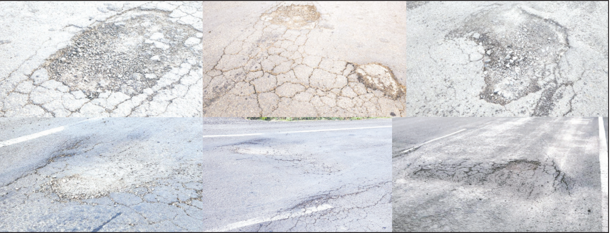
સાવરકુંડલા, તા. ૨૨ ગણતરીનાં દિવસો પહેલા જ નવો બાયપાસ શરૂ કરવામાં આવ્યો છે. આ બાયપાસ અમરેલી ને પિપાવાવ પોર્ટ, રાજુલા અને મહુવાને જોડે છે. હજી આ બાયપાસ શરૂ થયો એને જાજા દિવસો થયા નથી ત્યાં તો કેક હેકાણે ગાબડા પડી ગયા છે. અમુક જગ્યાએ રોડની સાઈડો બેસી ગઈ છે. આ બાયપાસમાં જે જે જગ્યાએ નાળાઓ આવેલા છે ત્યાં પણ સાઈડની સાઈડો બેસી ગઈ છે. આ ઉપરાંત એટલા મોટા ખાડા પડી ગયા છે કે ક્ષેત્ર વ્હીલર કે મોટા વાહનોને તો ફક્ત વાહનને નુકસાન થાય પરંતુ બાઈક ઉપર જતાં આવતા વાહનચાલકો જો આ ખાડાથી તેમની નજર ચૂંકાઈ જાય તો મોતનો ભેટો અનુસંધાન પાના ૬ ઉપર
